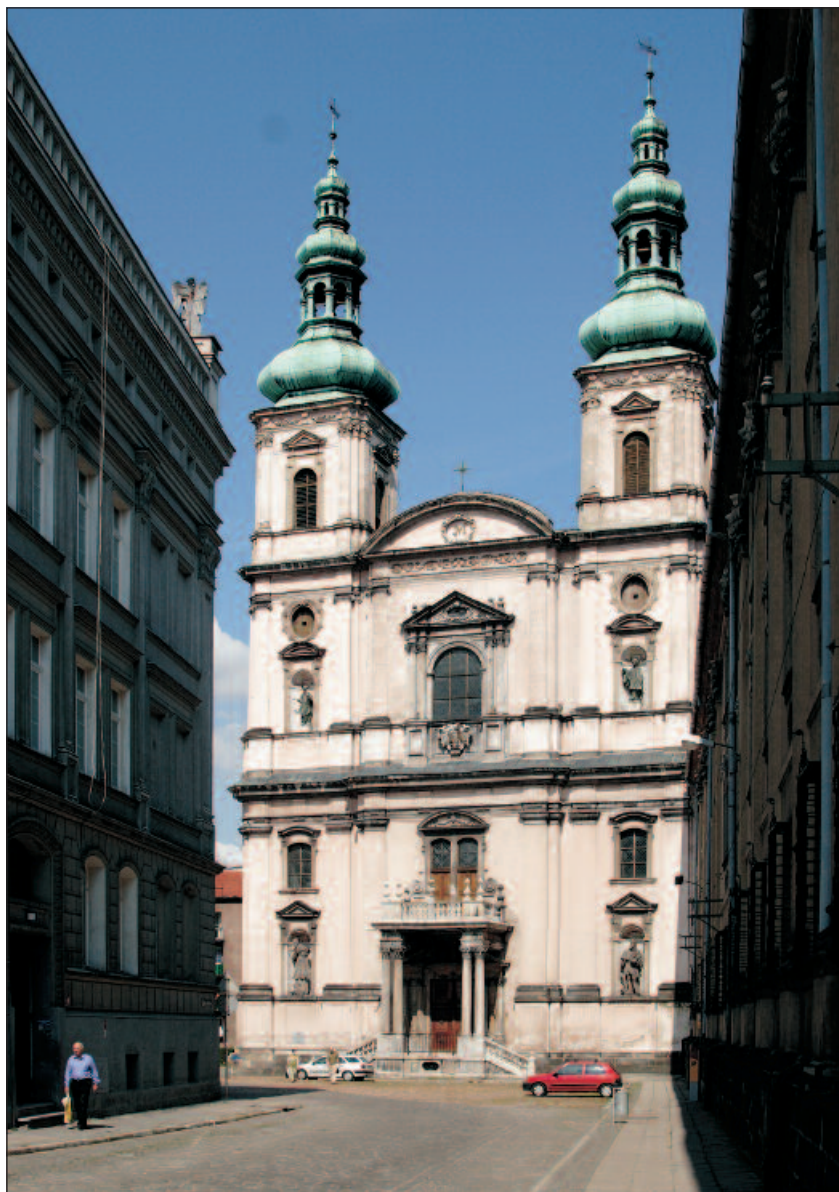
Fasada kościoła Wniebowzięcia NMP.
